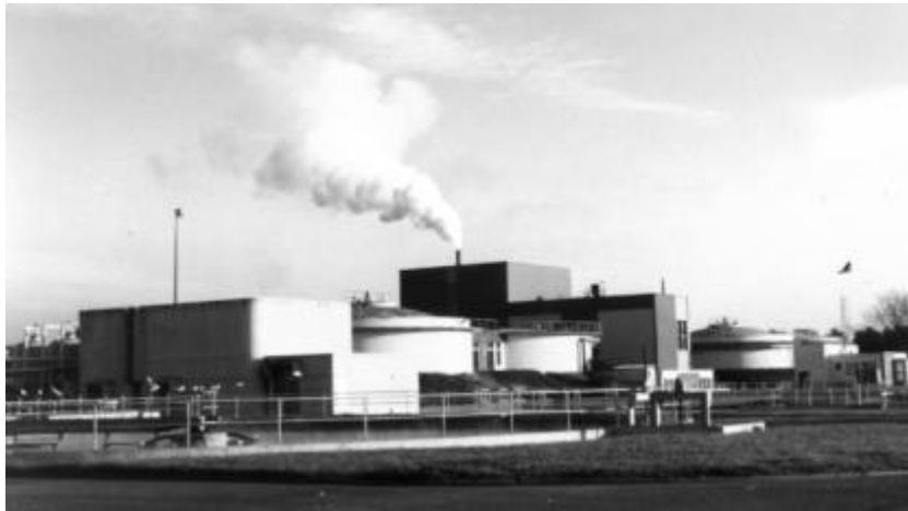
Photo 2 : Station d'épuration du District du Grand Caen
